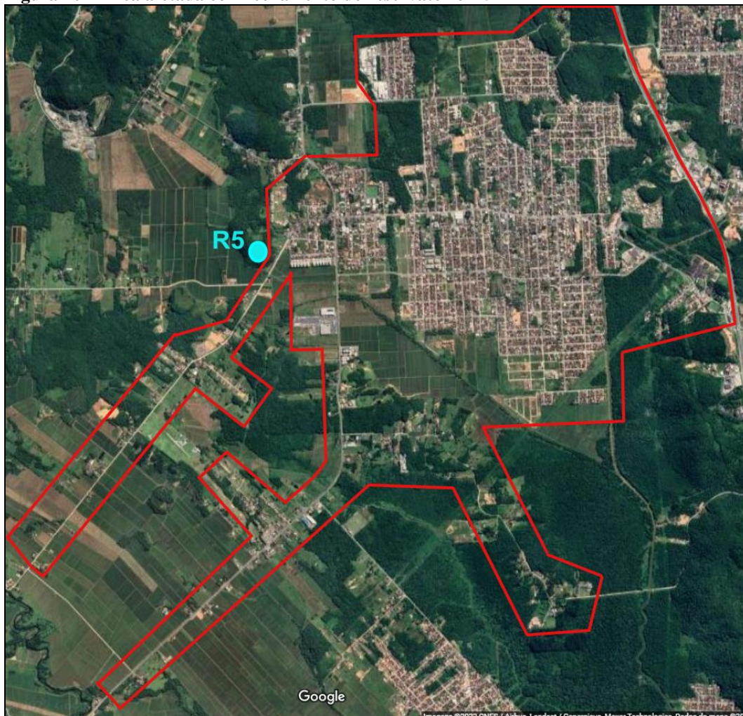
Figura 16 – Área afetada com fechamento do reservatório R5
