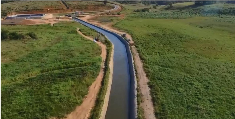
Figura 4 - Vista aérea do canal de captação da ETA Reis Magos
