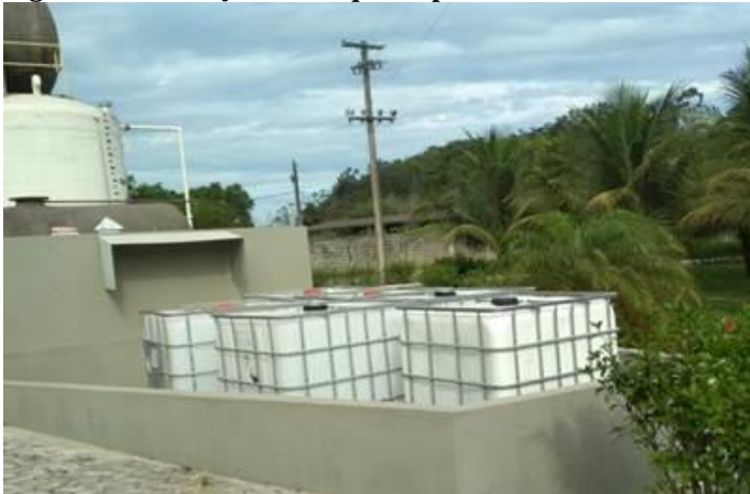
Figura 8 - Instalação de tanque de produto e bacia de contenção na ETA Santa Maria
