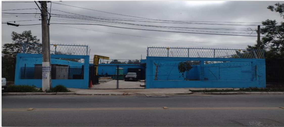
Figura 4: Vista Frontal da Elevatória de Esgotos Devide Perez
