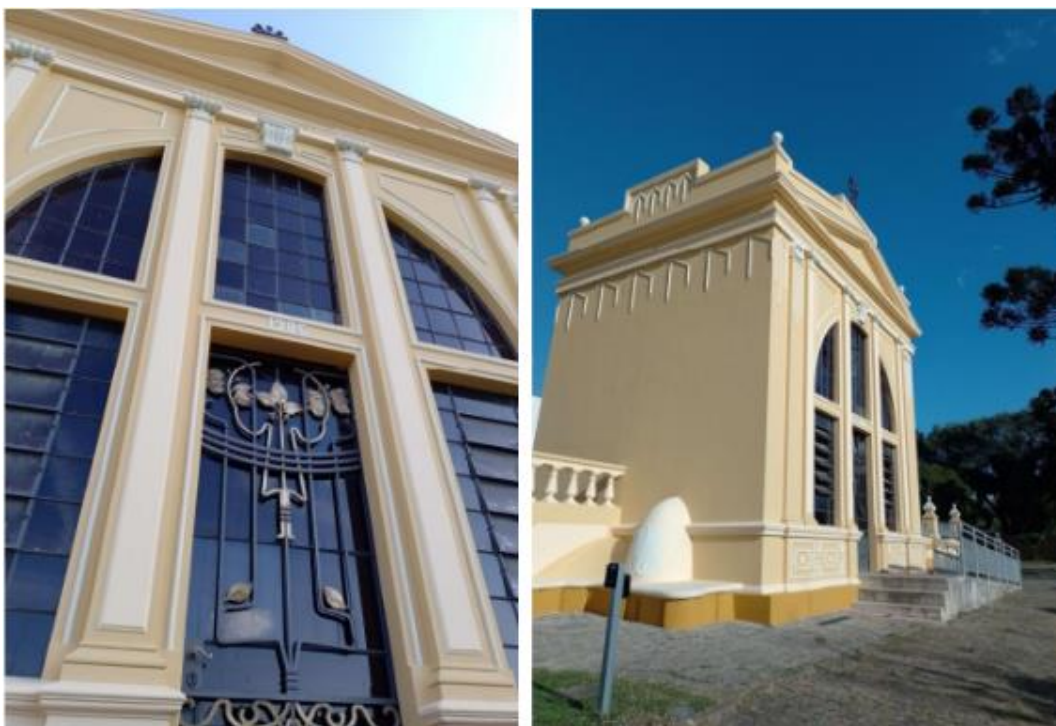
Figura 8 – Reservatório São Francisco em 2023
