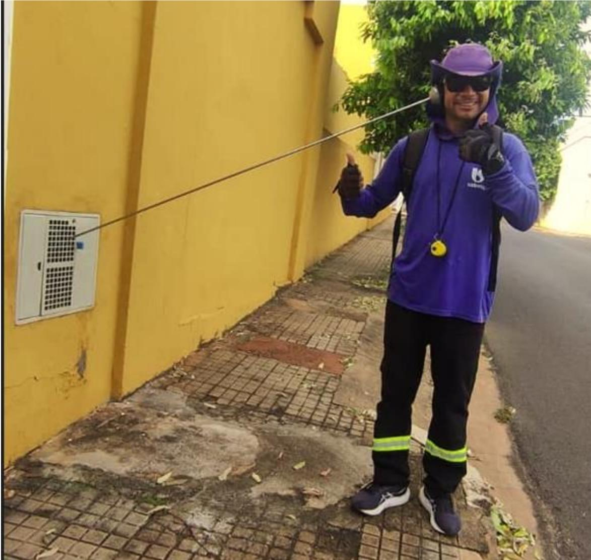
**Figura 1: Colaborador realizando pesquisa de vazamento de água utilizando a haste de escuta**
