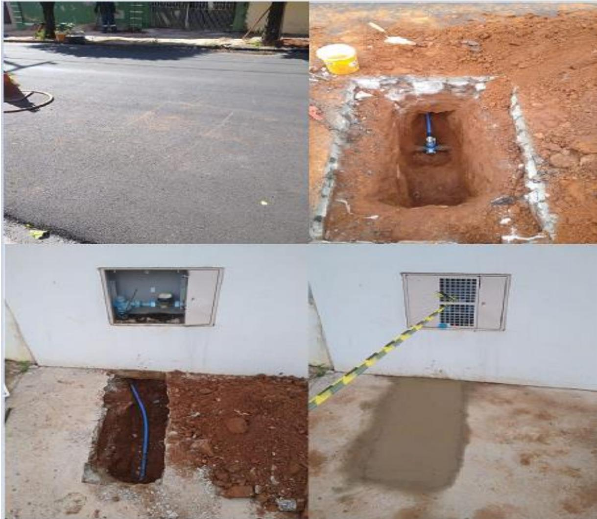
**Figura 3: Serviço de troca de ramal de água, vazamento não visível, utilizando método não destrutivo (MDN)**
