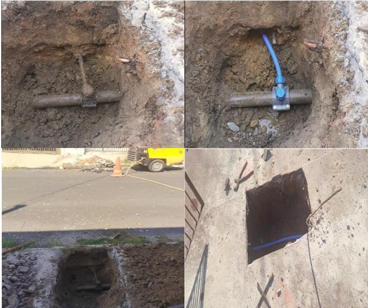
**Figura 4: Serviço de troca preventiva de ramal de água utilizando método não destrutivo (MDN)**
