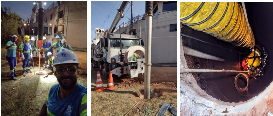
Desobstrução de poço profundo - coletor
