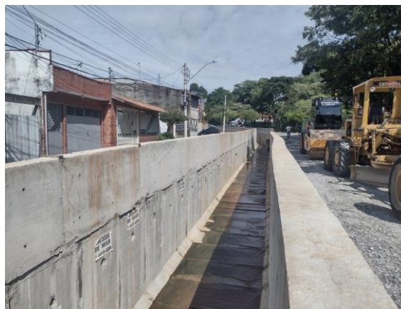
Córrego Armênio Soares - revitalizado
