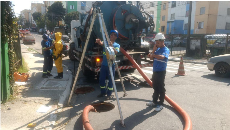
Limpeza de poço profundo
